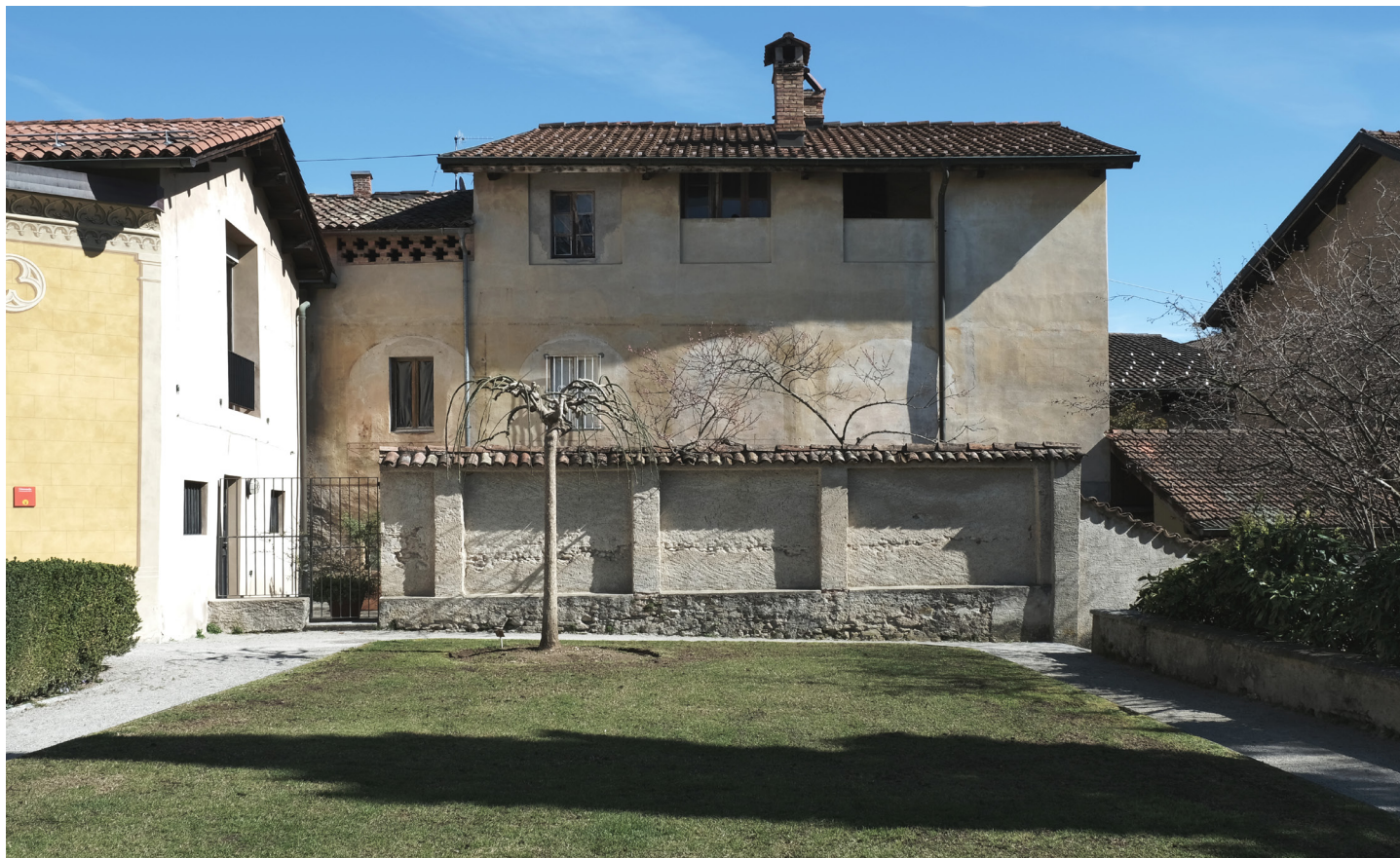
Stato di fatto Casa Rezzonico-Balmelli, fronte est. Foto @ studio pagnamenta
